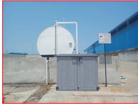
ภาพที่ 2-61 ตู้อุปกรณ์จัดการกรณีน้ำมันหกรั่วไหล
